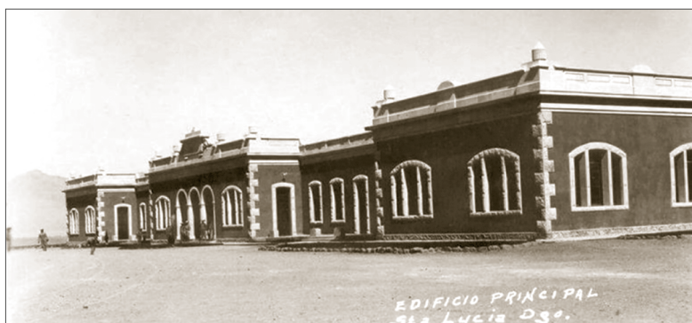
Edificio principal, Escuela Central Agrícola de Santa Lucía, Durango. Colección particular del autor.
