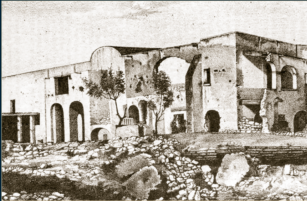
Ruinas del convento de Santa Inés, Puebla, por el ataque del 24 de abril de 1863. La presencia de Escobedo fue crucial para evitar que este reducto cayera, pero su brigada fue aniquilada en el proceso. Fuente: Luis Garcés, "Ruinas del convento de Sta. Inés". Litografía, 1863. Tomada de: Tirso Rafael Córdoba, El sitio de Puebla , México, Imprenta de José María Venegas, 1863, p. 92. Fotomecánico. Acervo INEHRM.
