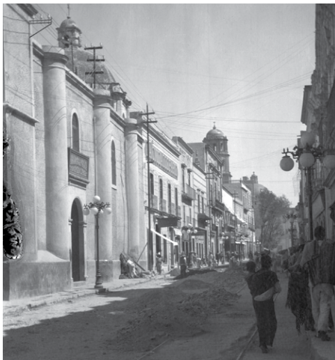
Trabajos de pavimentación en una calle de Querétaro. Al fondo Biblioteca Pública “Prospero C. Vega” y templo de San José de Gracia, 1917. SINAFO-INAH,
