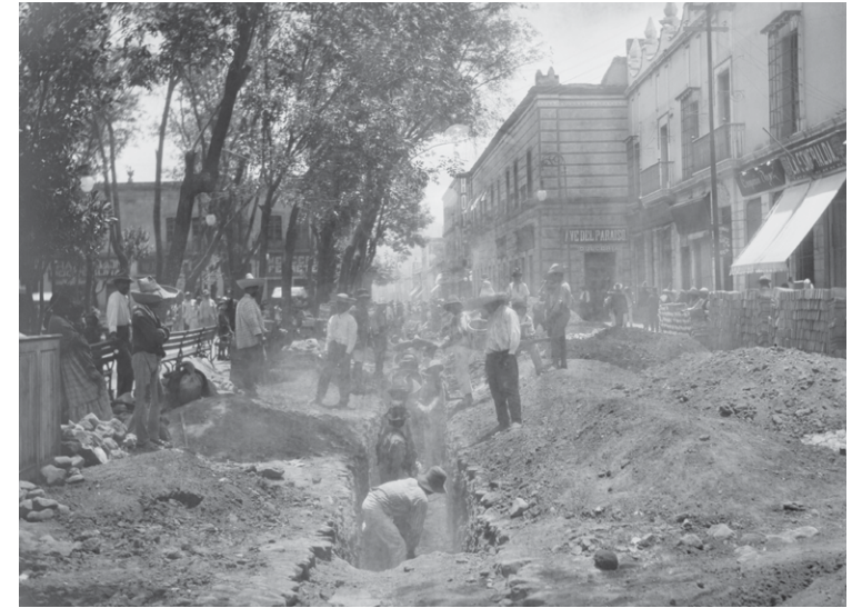
Obras de drenaje en la calle de Juárez a un lado del jardín Zenea. SINAFO-INAH.
